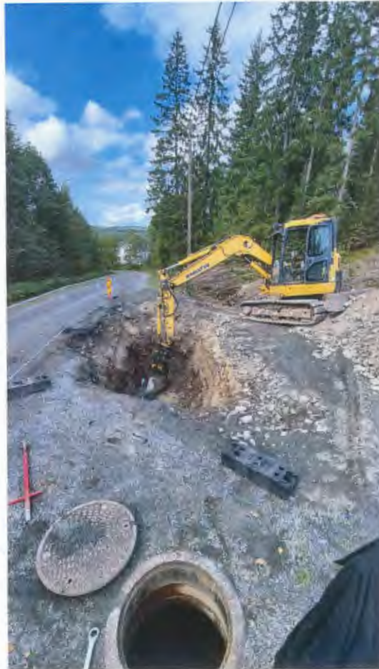
Utskiftning av asbestsementrør på 1814-feltet
