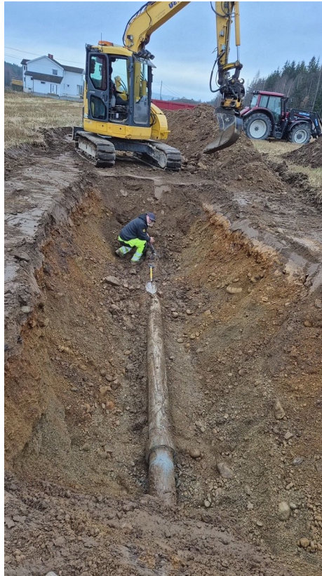
Reparasjon etter vannlekkasje, vår 2024
