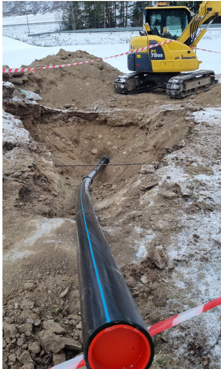
Trekking av rør på Matrand, vår 2023
